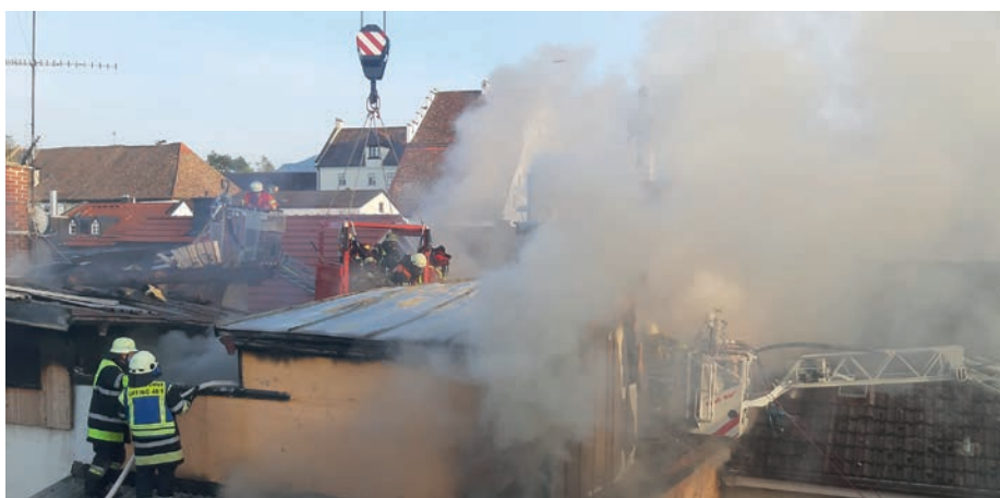
Entfernung des Blechdaches mit Unterstützung des Kranwagens der Feuerwehr Garmisch.
