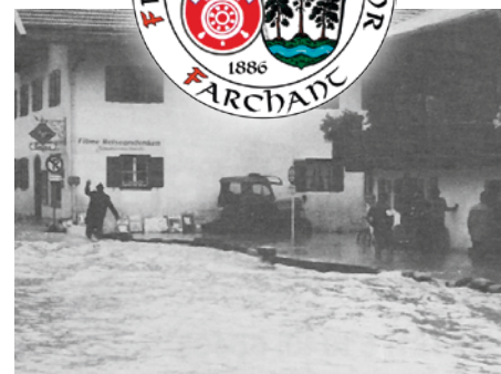
Hochwasser 1970 in der Hauptstraße.
