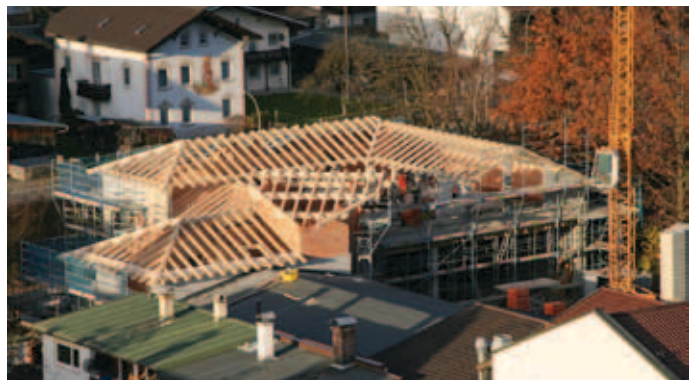
Die Rohbauarbeiten und der neue Dachstuhl aus der Vogelperspektive.
